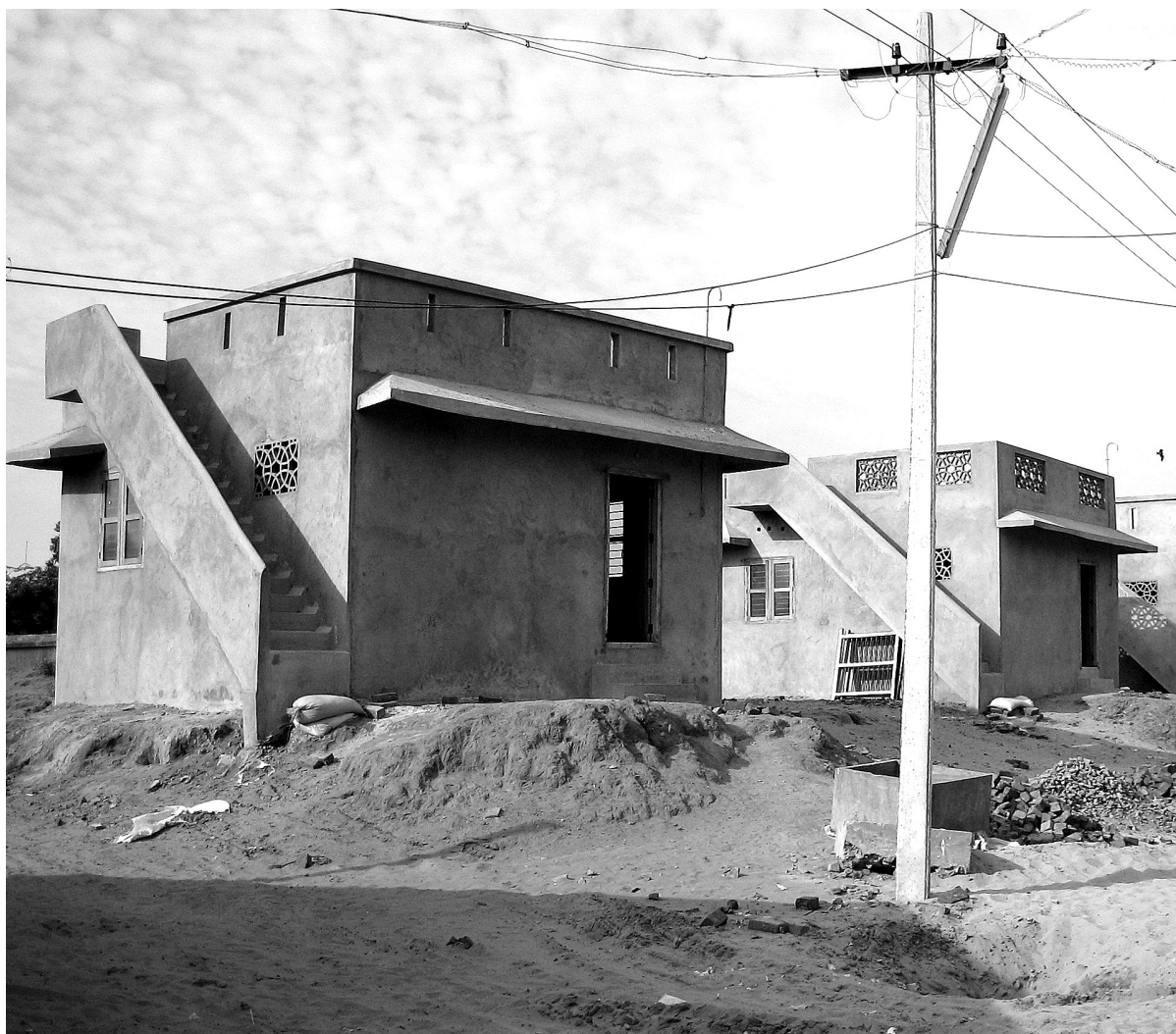
I Tranquebar er 1500 nye huse af denne slags under opbygning.
