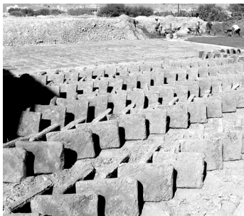
Fremstilling ved håndkraft af mudder-byggesten til de karakteristiske huse i det sydlige Yemen.
