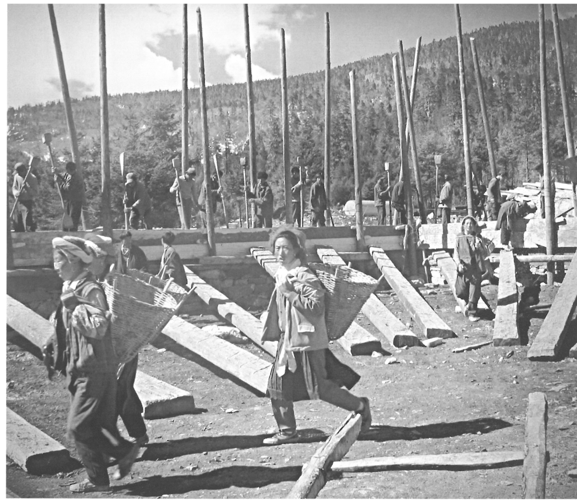
Når murene skal bygges bærer kvinderne jorden i kurve på ryggen.
