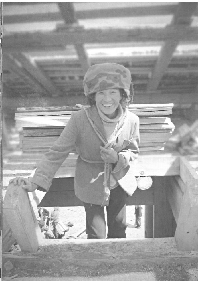
Kvinderne bærer tagbrædderne op og mændene lægger taget.
