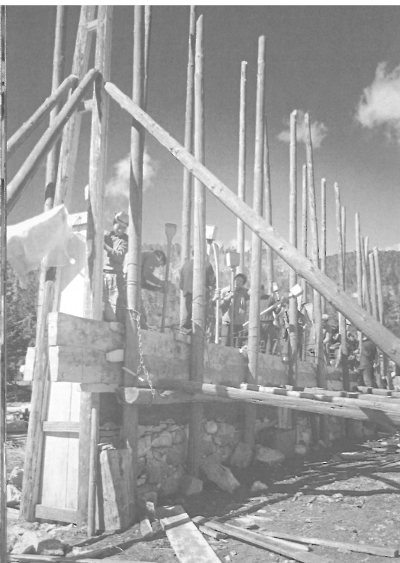
Mændene støder jorden sammen for at lave en solid mur. Det er tredje dag efter gedong hlong festen og taget er ved at blive lagt.
