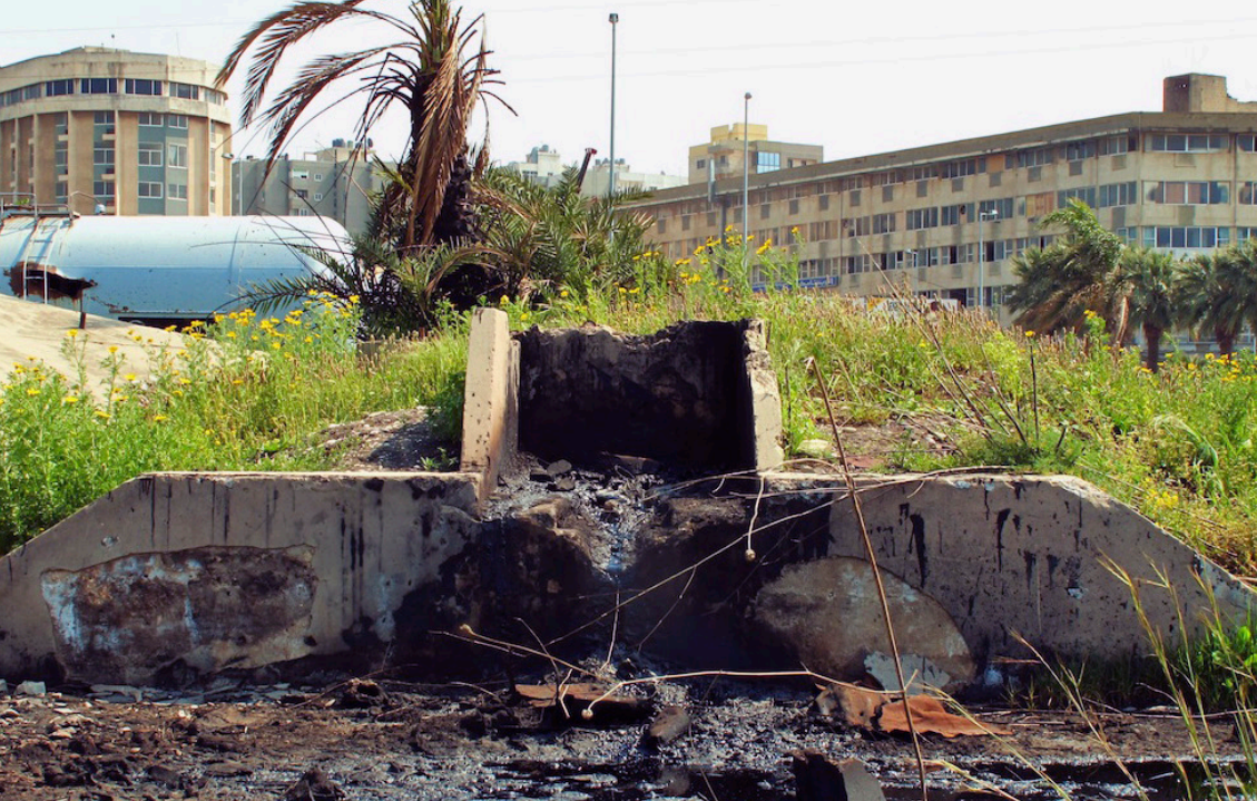
Murbrokker ved nedlagt jernbane i Tripoli, Libanon. Foto: Inge-Merete Hougaard.
