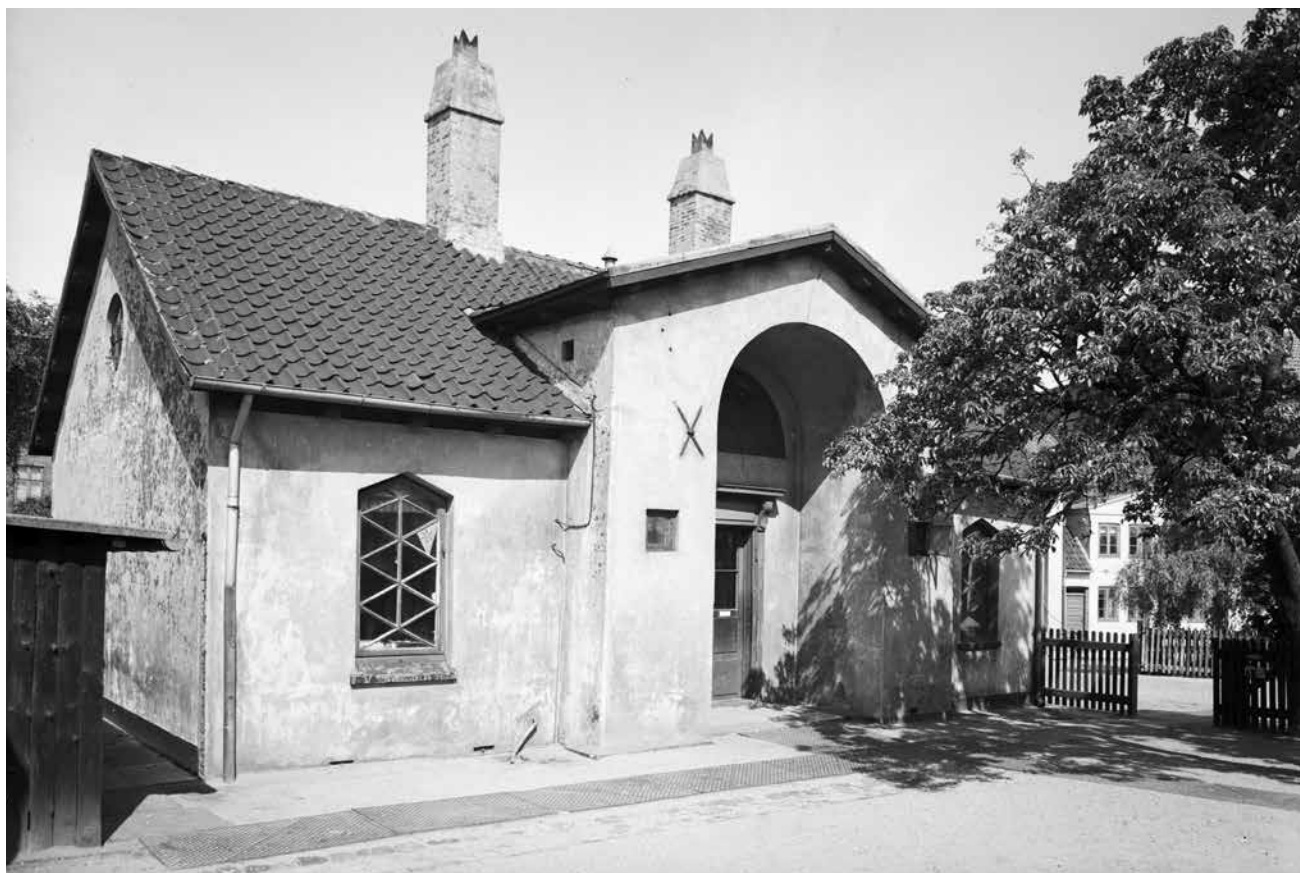
Det tidligere karantænehus i Helsingør, som modtog fremmede syge, der kom til byen. Huset er opført senest i 1811. Da Nordbanen blev ført igennem til havnen i 1890/91, overgik karantænehuset til DSB og/eller telegrafvæsenet. Huset lå ud for stationens varehus ved Svingelport/Jernbanevej. Her fotograferet i 1953, året før nedrivning af bygningen.
