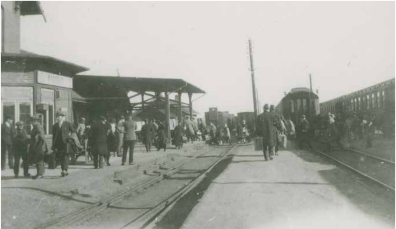
Helt uafhængigt af jernbanekommissionen fik Paddborg station en central betydning i kraft af den nye grænse. Det betød en stor vækst i det lille bysamfund, der blev Sønderjyllands sidst anlagte stationsby. Her ses stationen ca. 1923. I spor tre længst til højre er det danske eksprestog ankommet. Alle passagerer skal skifte til det tyske tog i spor 2. Spor 1 er belagt med godsvogne, så langt øjet rækker. De rejsende strømmer tværs over sporene for at komme igennem pas- og toldkontrollen – en forudsætning for at komme med det tyske tog. Det var en udfordring at gøre en så lille station til grænsestation. En ny stationsbygning blev derfor opført i 1928.
