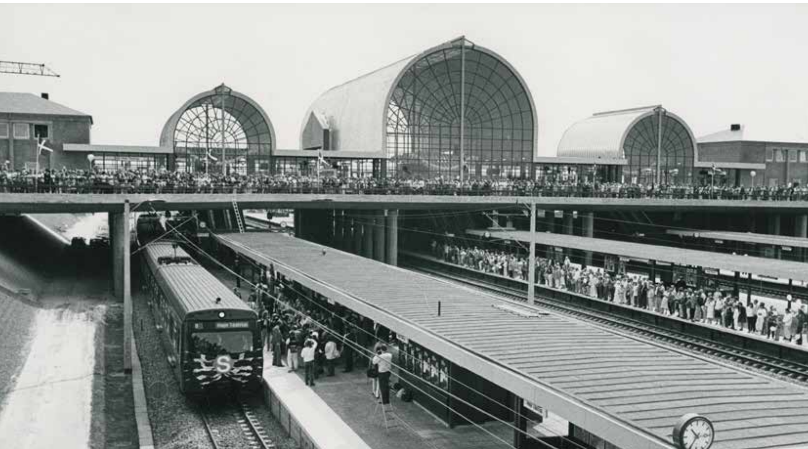
Høje Taastrup Station. Det lå som en fast bestanddel af planerne for Storkøbenhavns egnsudvikling, at der skulle sættes på bebyggelsen langs Taastrup- og Køge Bugt-fingrene. Med den betydelige bosættelse i Vestegnen blev der behov for en større station med både lokale og nationale togforbindelser. Stationen i moderne design tilknyttet et lokalt forretnings- og boligkvarter kunne indvies i 1987. Udover passagertrafik skulle stationen omfatte et godsbanecenter og et S-togsdepot. På billedet er mange folk stimlet sammen til den officielle indvielse (Danmarks Jernbanemuseum).
