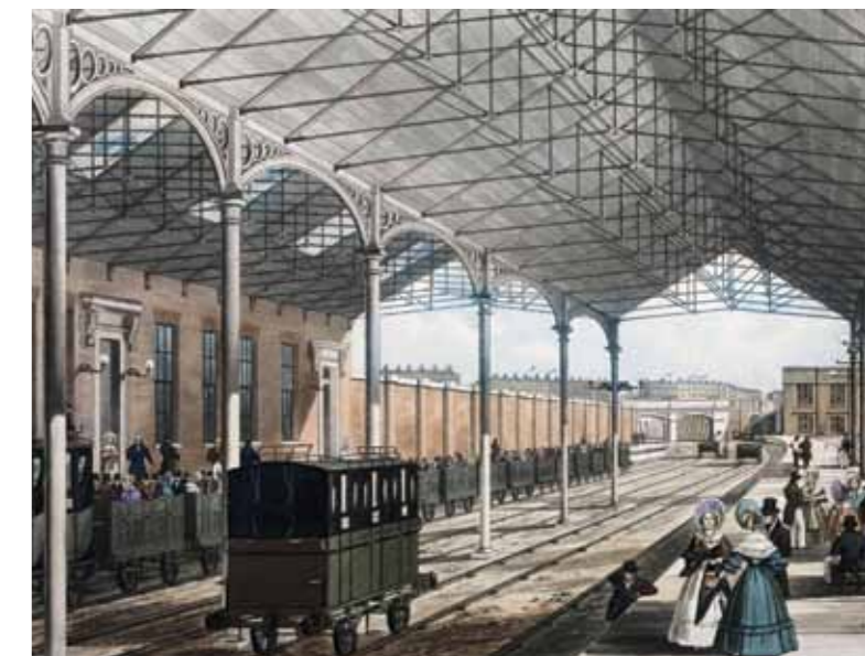
Figur 6: Jerntaget på stationen Euston Terminus (1837), af Charles Fox under tilsyn af Robert Stephenson.
