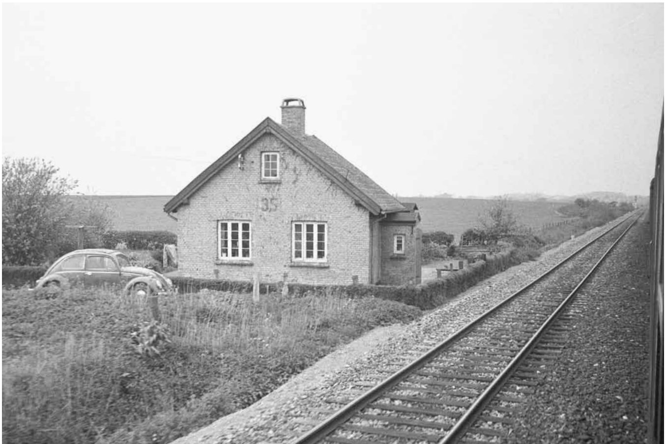
Figur 8: Banevogterhus nr. 35 i Sværdborg få kilometer syd for Ring. Huset, der er forsynet med et lille skildderhus i facaden ud mod jernbanen, er af den type, der blev bygget mange af i forbindelse med anlægget af Sydbanen i 1868-70. Huset havde en kvadratisk grundplan og vinduer i gavlen. Det bestod af forstue, køkken og to værelser, og det indvendige beboelsesareal var kun ca. 34 m 2 . Banevogterhuset i Ring har været næsten identisk med det i Sværdborg (J. Bruun-Petersen fot.).
