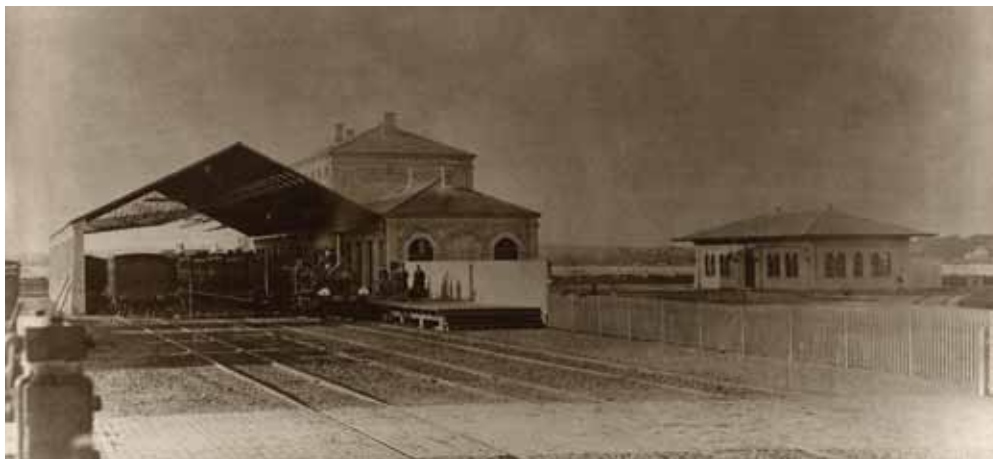
Foto af det helt nyanlagte stationsområde i Nyborg i 1865. Billedet giver et flot indblik i det miljø, som ikke blot stationen, men også en banegårds øvrige bygninger tilsammen skabte sammen med sporet, pladsen og de tilliggende vejforbindelser. Til højre det særskilte gæstgiveri i egen bygning (Danmarks Jernbanemuseum).
