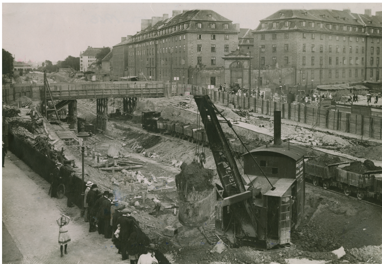
Udgravning til boulevardbanen ca. 1916, lige ved Sølvgades kaserne, senere DSB's Generaldirektorat. Flytningen i 1911 af Københavns Personbanegård til den nuværende placering forudsatte en jernbaneforbindelse til Østerport, så Nordbane-, Holte- og Klampenborgtogene ikke længere skulle via Skt. Jørgens Sø, Nørrebro og de mange overkørsler her. Det samlede anlæg påbegyndtes i 1909 og stod færdigt i 1917, dog for sporene til Holte- og Nordbanetogene først i 1921 (foto: ukendt, DJM).
