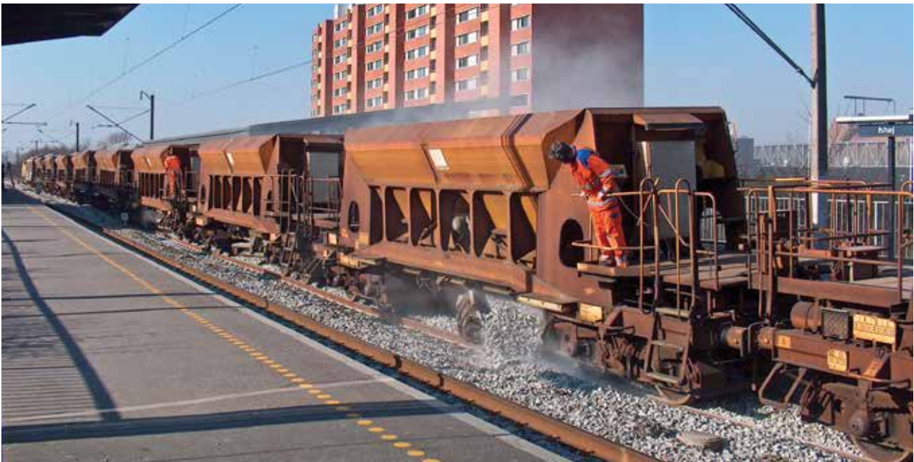
Svenske Banverket i færd med en sporfornyelse på Ishøj station i marts 2007. Nye skærver udlægges fra arbejdstoget (foto: forfatteren).
