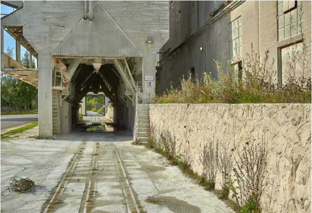
Gardes kalkbane var oprindelig smalsporet, men efter at den normalsporede bane mellem Køge og Stubberup var blevet en realitet i 1879, fik kalkbanen en ekstra skinne, så den også kunne anvendes af normalsporede tog (foto: Flemming Wedell, 2007).
