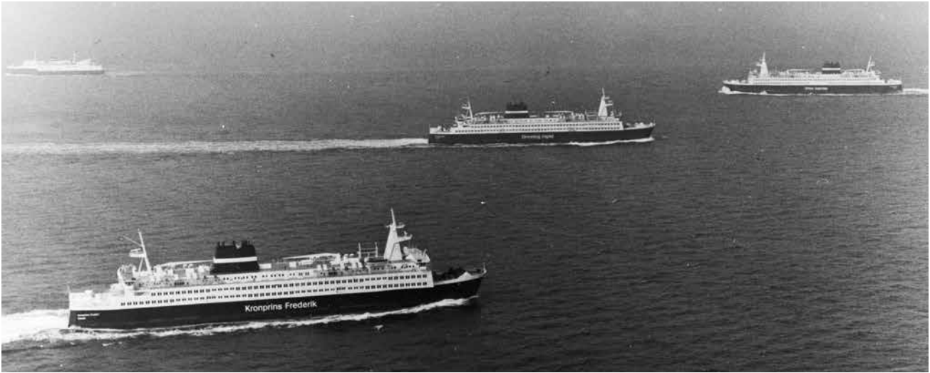
Frem mod 1997 og åbningen af den faste Storebæltsforbindelse begyndte udskillelsen af færgerdrift fra DSB som et led i den proces, der også omfattede udskillelse af en selvstændig infrastrukturforvalter, Banestyrelsen. Foto viser de tre nye intercity-færger på Storebælt i 1981 (Danmarks Jernbanemuseum).
