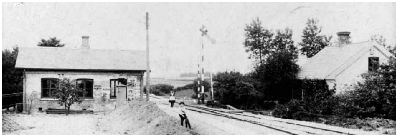
Holmstrup Holdeplads omkring århundredskiftet. Som de fire andre holdepladser bestod Holmstrup af to bygninger: en lille ekspeditionsbygning med ventesal og billetkontor (til venstre) og et banemesterhus til bolig for holdepladsens bestyrer (til højre) (Danmarks Jernbanemuseum).
