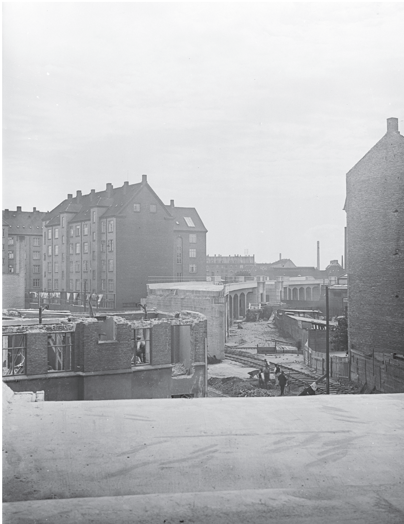
Bygning af højbanestrækningen ved Nørrebro station, 1929. Der måtte bl.a. nedrives beboelsesejendomme. Anlæg af en højbane var i det hele taget meget omkostningskrævende, og derfor fik principbeslutningen i 1904 om anlæg af en løftet bane i større dele af København – som visse steder i udlandet – aldrig en chance (foto: ukendt, DJM).
