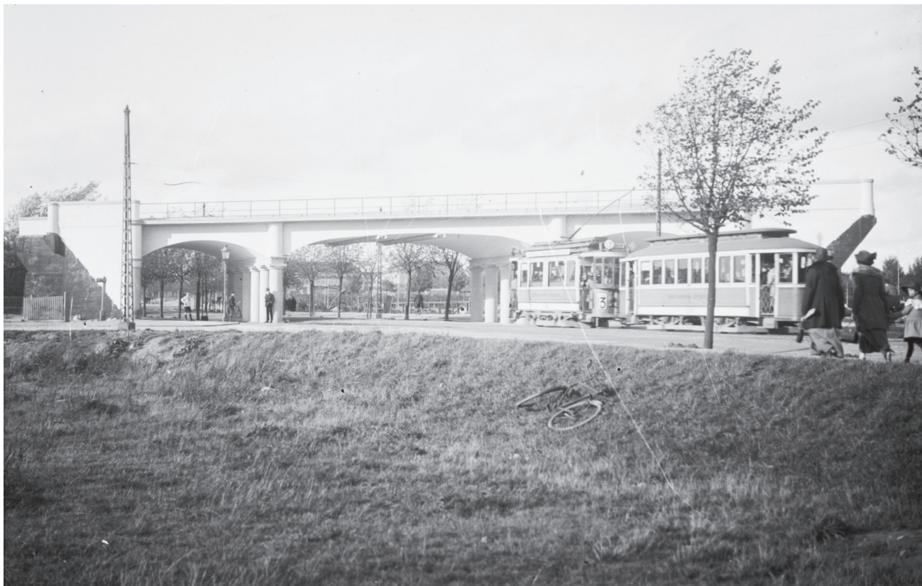
Nyopført viadukt over Borups Alle i København, foreløbigt uden tilsluttende banedæmninger, ca. 1924. S-banen Frederiksberg-Vanløse-Nørrebro-Hellerup etableredes på den planlagte ringgodsbane i henhold til lovgivning fra 1919. Tanken var, at der midlertidigt kunne køres persontrafik, men med faldende godstrafik efter 1920 var anlægget efter det oprindelige formål omtrent overflødiggjort. Med nærbanetrafik på strækningen var den ikke spildt og et gammelt løfte til især Frederiksberg Kommune kunne omtrentlig indfries. Planlægning i en hastigt ekspanderende metropol var ikke let (foto: ukendt, DJM).
