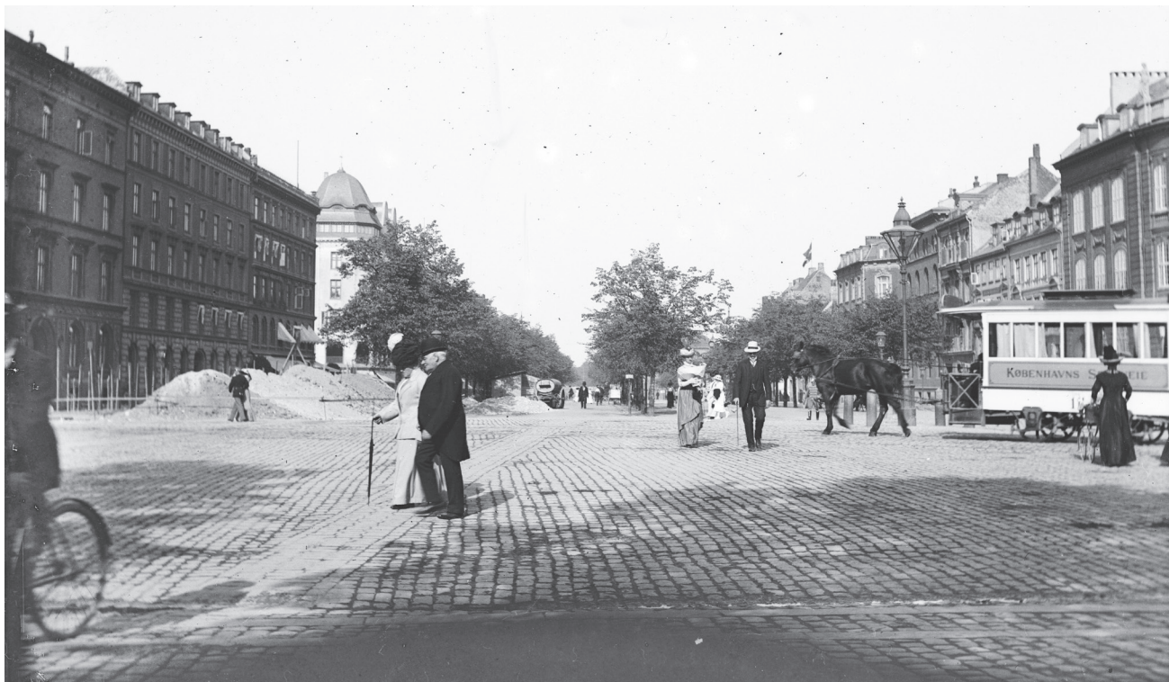
Hestesporvogn på Nørrevoldgade i København, hvor der senere blev udgravet til boulevardbanen og Nørreport station, 1911. Boulevardbanen, der blev anlagt fra 1915, skulle tjene både nær- og fjerntrafik. Spørgsmålet om elektriske tog blev derfor aktualiseret som følge af de voldsomme røggener, damplokomotiverne udsatte passagerne for, blev dog i første omgang afvist af Statsbanerne, der frygtede for økonomien (foto: ukendt, DJM).
