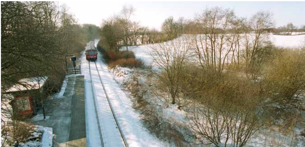
Af praktiske grunde blev holdepladser på Lille Nord fra Hillerød til Snekkersten bodelt, som var det en S-togsstrækning (foto: Peter Thornvig/DSB, 2001).
