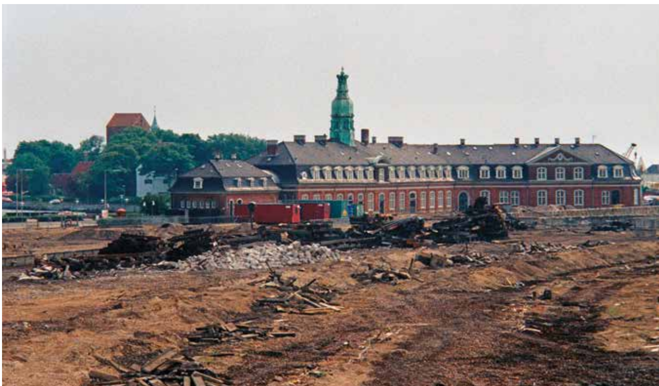
Et års tid efter at Storebæltsoverfarten mellem Korsør og Nyborg var nedlagt, var der i juni 1998 fuld gang i oprydningsarbejdet i Korsør (foto: forfatteren).
