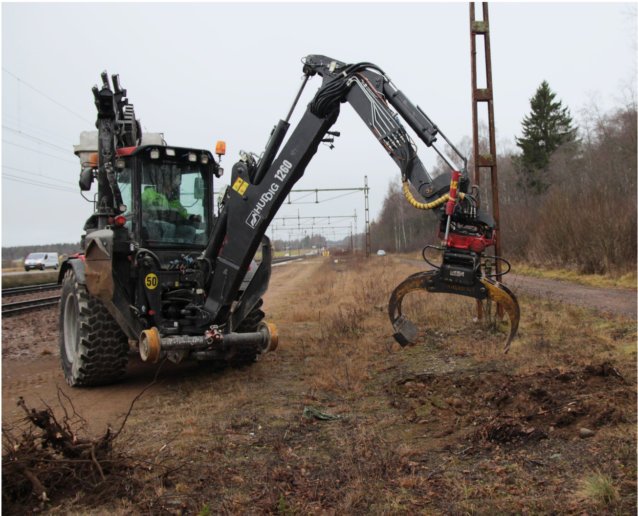
Billede 21: Oprykning af kratrødder kan være mere effektivt end traditionel motormanuel rydning for at forhindre tilgroning (foto: Jörgen Wissman).
