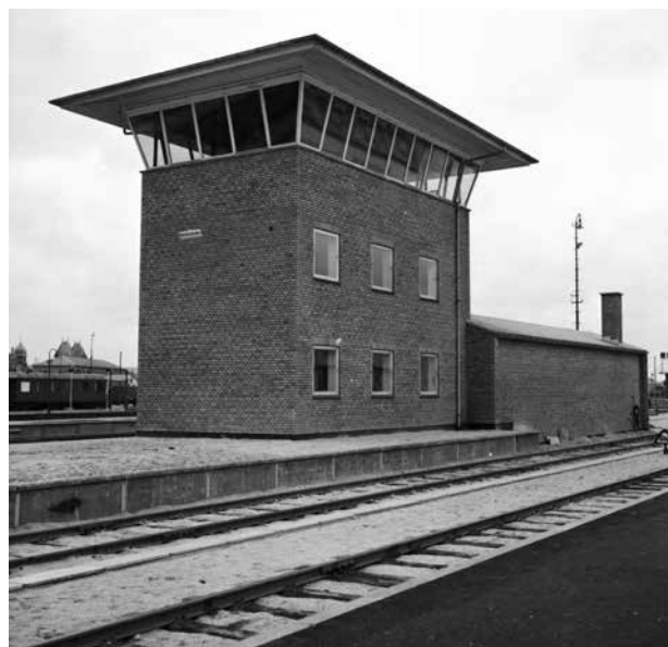
Her ses den nye signalpost på Odense Station i nydelig rødstensarkitektur og med godt overblik for sikkerhedsassistenterne. Året er 1954 (Jernbanekilder.dk/Danmarks Jernbanemuseum).
