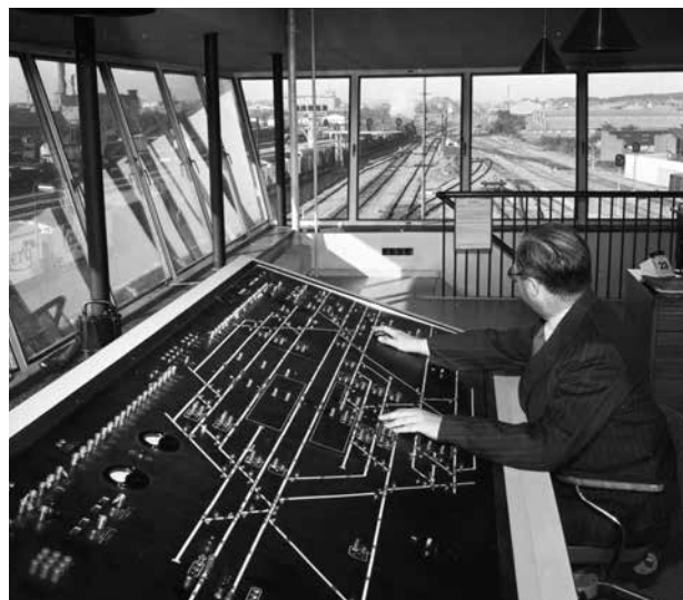
Fra tidligt i 1950'erne arbejdede DSB på at forbedre sikkerheden og effektiviteten på banenettet. Her er vi i den nye signalpost på Odense Banegård i 1954. Sikkerhedsassistenten sidder ved betjeningstavlen til relæsikringsanlægget (Jernbanekilder.dk/Danmarks Jernbanemuseum).
