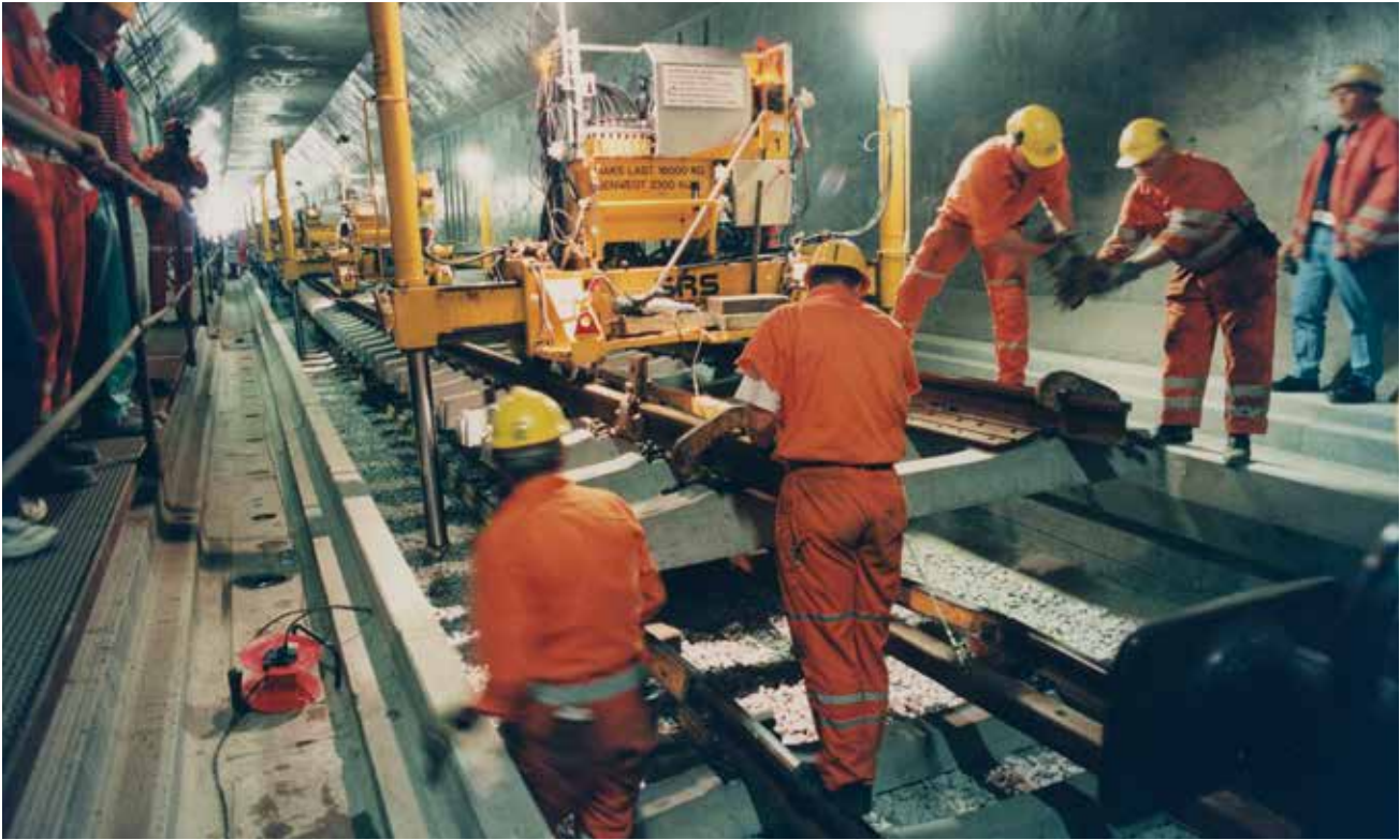
Som et resultat af Storebæltsforliget skulle jernbanetrafikken føres gennem en tunnel under Østerrenden og via en kombineret lavbro over Vesterrenden. Efter et langvarigt og til tider problematisk forløb, hvor den skotske boremaskine på et tidspunkt traf på en vandlomme, og tunnelen blev oversvømmet, var skinneforbindelsen klar i 1995, og regulær togtrafik påbegyndtes den 1. juni 1997. Broen blev åbnet for biltrafik i pr. 14. juni 1998. Her er arbejdere i gang med at lægge sveller og skinner (Peter Thornvig/Danmarks Jernbanemuseum).
