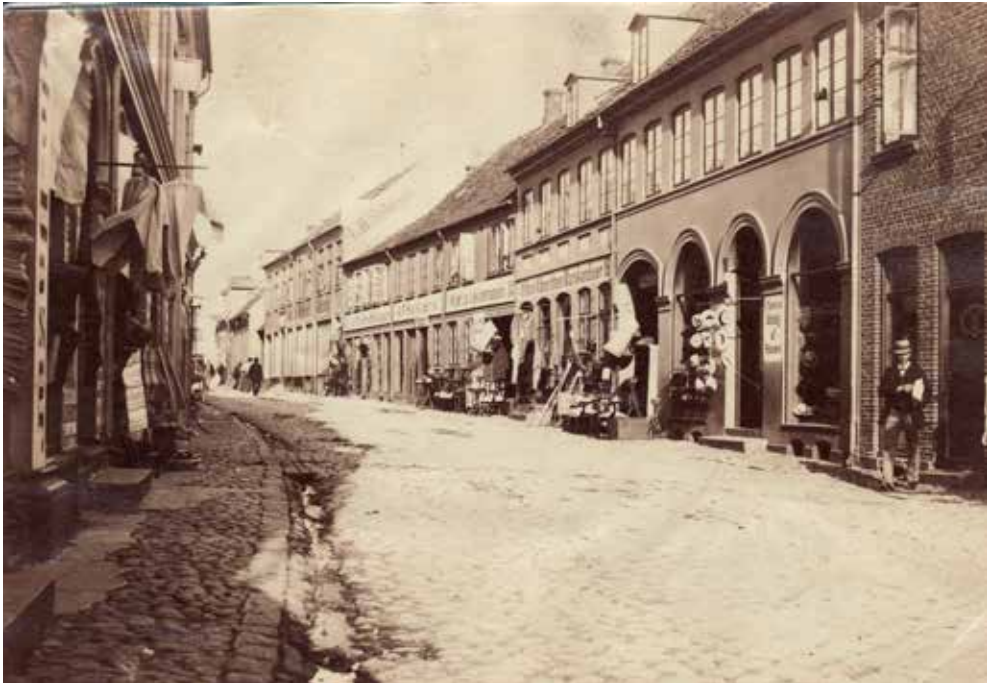
Vestergade i Viborg o. 1900. Nogle huse har fået store butiksruder – men i samme bredde som vinduerne på første sal. Sådan var det typisk i bindingsværkshusene – også dem, hvor bindingsværket var pudset for at få huset til at ligne en muret ejendom. Der er dog stadig et par forretninger, der blot har helt almindelige vinduer til gaden. Foto: Viborg Museum.
