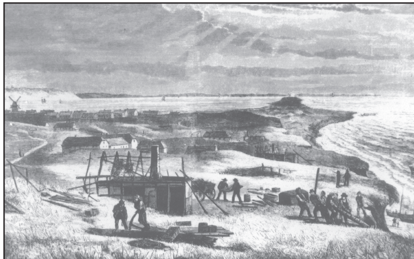
Figur 1. Fra Agger. Bygninger ved Agger nedbrydes, og byggematerialer genbruges ved genopførelse andre steder. Af P. Hauberg i Illustreret Tidende , årg. 17, nr. 861, 26.3.1876.
