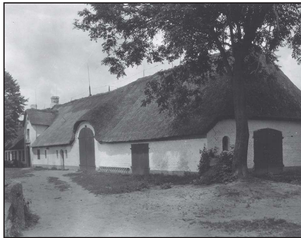
Fig. 5: En dansk/slesvigsk enlænget gård af Wohnstallhaus-typen. Ligesom gårdene på Angel var disse gårde delt på tværs, således at der var beboelse i den ene ende og stald/lade i den anden. I modsætning til Angelgårdene var de imidlertid ikke opført i højremskonstruktion, men i „almindeligt“ spærtagsbindingsværk. I modsætning til danske gårde var de desuden meget brede. Foto: Halvor Zangenberg, Nationalmuse- ets bondegårdsundersøgelser.
