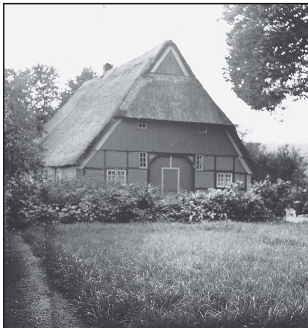
Fig. 3: En tysk entlænget gård i højremskonstruktion (hallehus eller saksisk gård, som bondegårdsforskerne tidligere kaldte denne hustype) i Kellinghusen i Holsten. Foto: Kai Uldall, Nationalmuseets bondegårdsundersøgelser.
