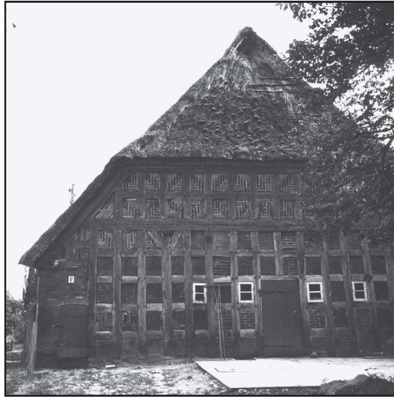
Fig. 4: En angelsk enlænget gård i højremskonstruktion. I modsætning til hallehuse- ne rummede disse gårde ikke en diele med et ildsted, og de havde ikke port i gavlen. De var derimod delt på tværs, således at der i den ene ende af huset var beboelse, mens der var stald i den anden. Porten til loen lå på gårdens langside. Foto: Svend Jespersen, Nationalmuseets bondegårdsundersøgelser.
