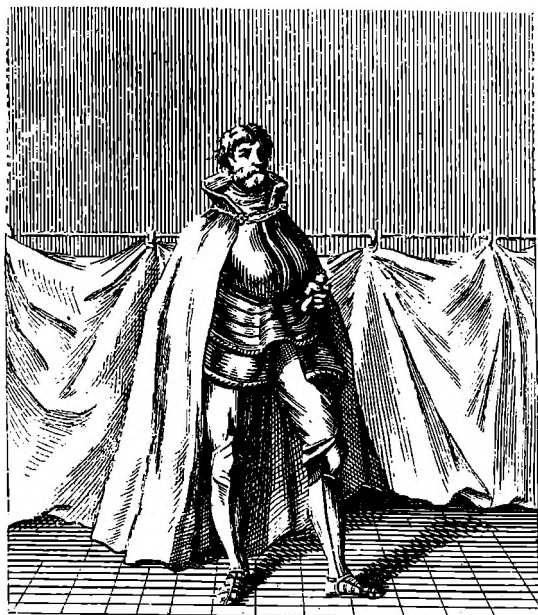
Fig. 6. Højaltertavlen nordre Yderdør.
