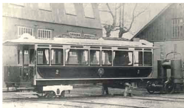
Dampsporvogn nr. 2 med dampmaskinen trukket ud. Sporvognen kørte i 1881 for Strandveiens Dampsporvei Selskab.
