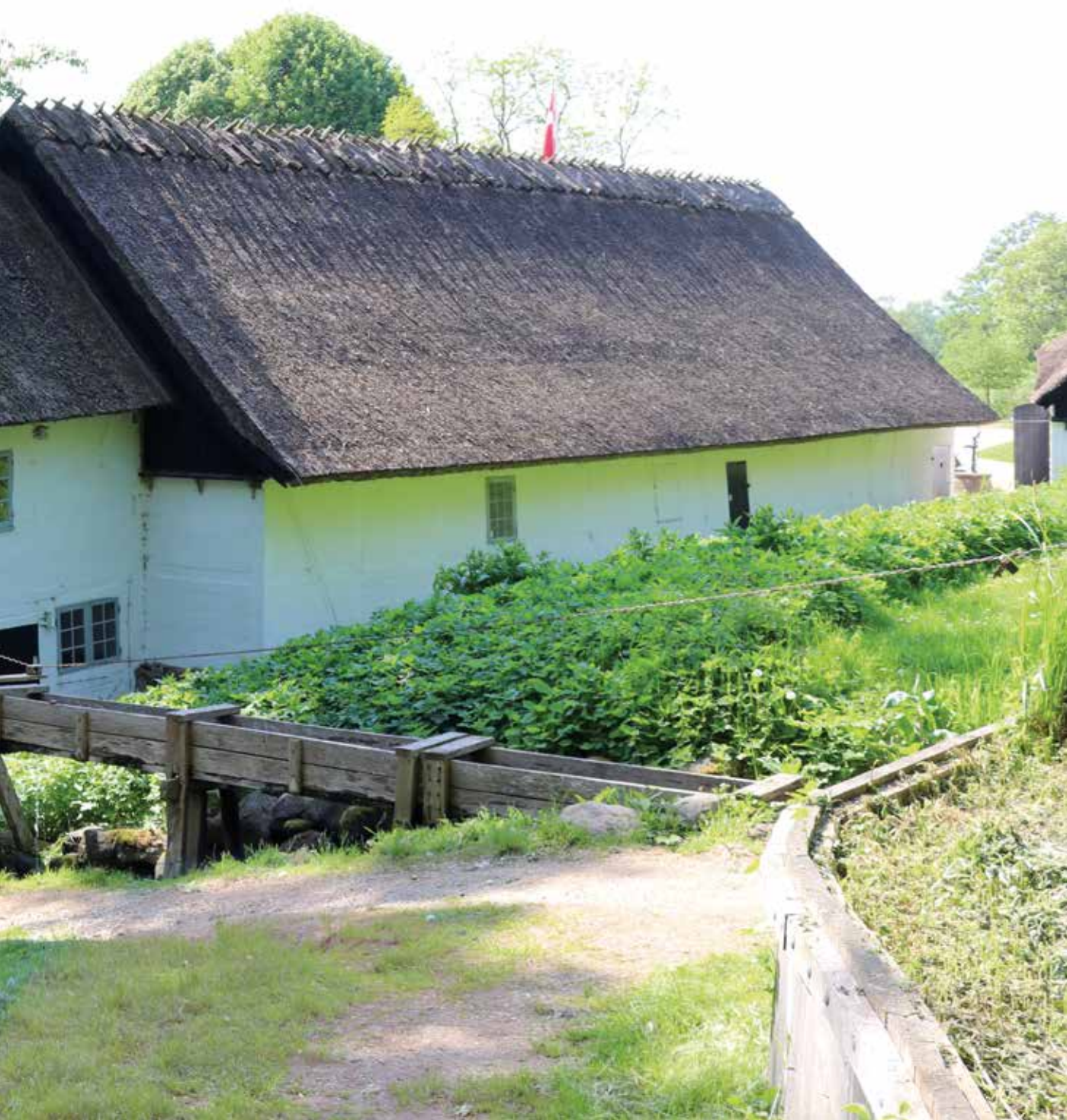
Tadre Mølle med trækanalen, som fører vandet fra kilden ned over overfaldshjulet på møllen. Foto: Nynne Sørgaard, Nationalpark Skjoldungernes Land.
