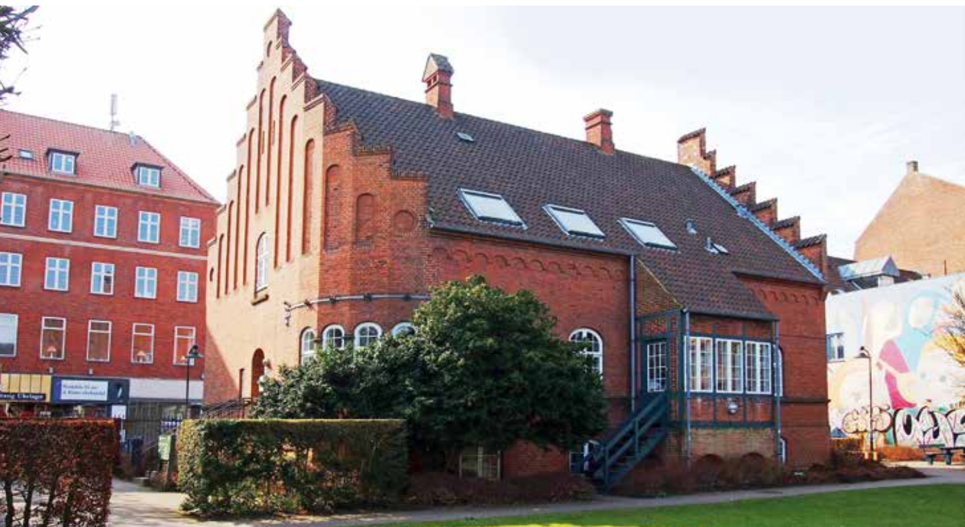
Figur 128. Algade 31 fra havesiden med det runde hjørne og de famøse ovenlysvinduer. Foto: Kurt Buchtrup.
