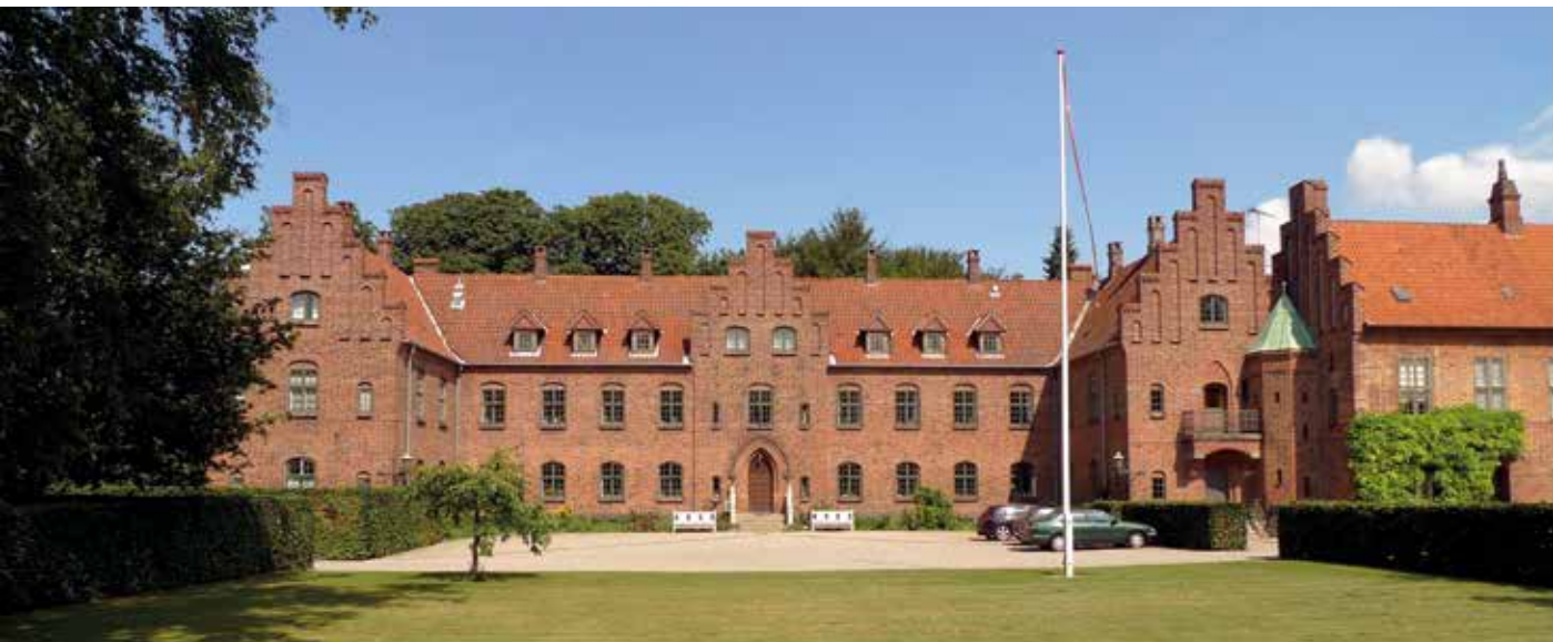
Figur 82. Damernes Fløj set fra syd. Så harmonisk fremtræder sammenføjeingen af den nye og den gamle bygning, selvom der er ca. 340 år imellem dem. Foto: Søren Lyder Jacobsen/Roskilde Kloster.
