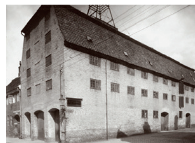
Sukkerhuset omkring forrige århundredskifte med telefonantenne på taget. Der var tale om solidt byggeri, der kunne overleve senere tiders ombygning til andet brug, endog brandstation i begyndelsen af 1900-tallet. Foto: Kristian Hude. Ca. 1900. Roskilde lokalhistoriske Arkiv.
