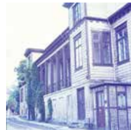
Maglekilde Vandkuranstalt imponerende facade kunne ses langt op i 1900-tallet. Her boede Dirckinck-Holmfeld med sin kone og børn. Foto af Arthur Fang, u.å. Roskilde lokalhistoriske Arkiv.
