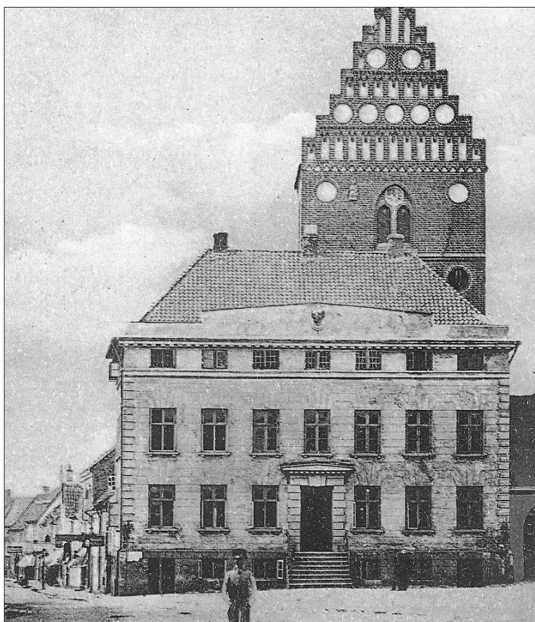
Det nye bystyre vedtog som noget af det første at modernisere og udvide det gamle rådhus. Begrundelsen var blandt andet, at den gamle arrest var helt uforenelig med nye principper i tiden om en mere human behandling af arrestanter. Den nye administration krævede også mere plads. Ukendt fotograf. 1860'erne. Roeskilde lokalhistoriske Arkiv.
