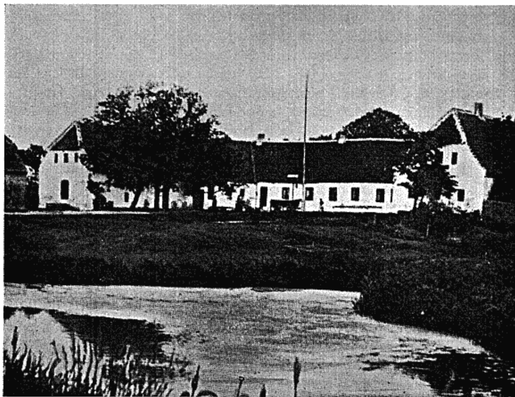
Barndomshjemmet Åstrup, hovedbygningen opført af Chr. H. Niensens fader i 1820'erne.
