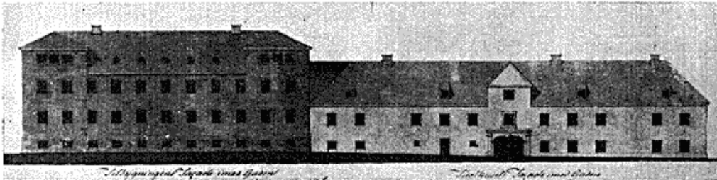
Tugthusets facade i 1843. Midt i bygningen ses porten, der var den eneste indgang. Det høje hus til venstre er en planlagt nybygning. (Rigsarkivet.)
