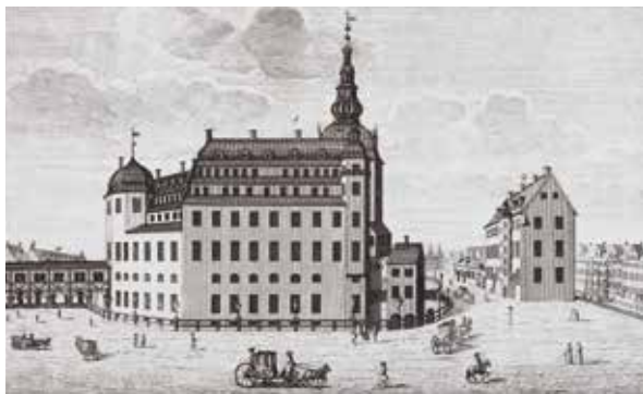
Det middelalderlige Københavns Slot var forbundet med Biblioteks- og Kunstammerbygningen via en løngang i bindingsværk, der forbandt den kongelige etage med biblioteksbygningen. De overdækkede forbindelsesgange var i øvrigt et karakteristisk træk ved det gamle Københavns Slot. De forbandt også slottet med ridehuset og de kongelige stalde, så de kongelige uden at blive set kunne gå ned og dyrke deres lidenskab for heste eller ridning. Foto: Det Kongelige Bibliotek.
