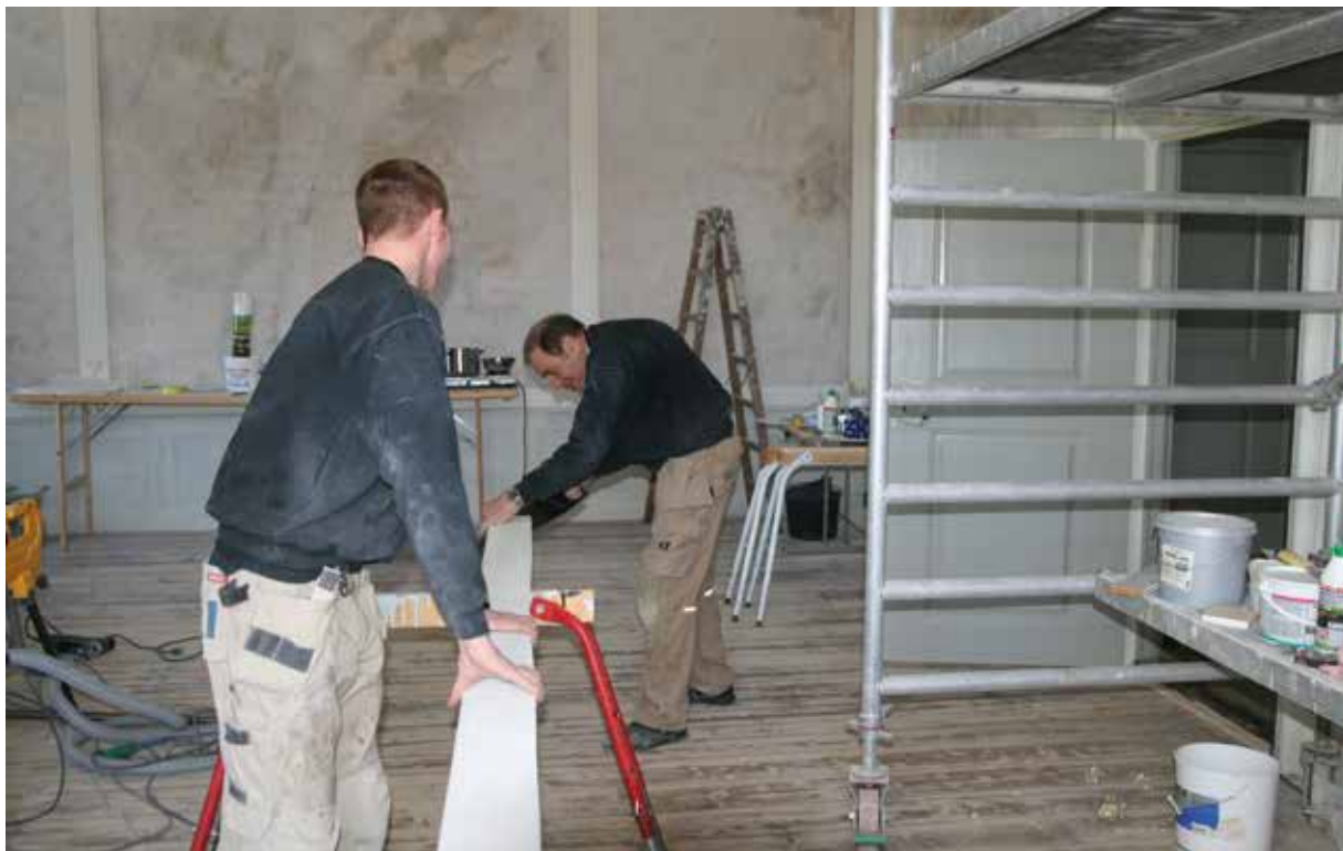
Gammel Estrup er fredet, og det er derfor af altafgørende betydning, at museet kan trække på de bedste og mest velkvalificerede håndværkere, når bygningen skal restaureres. Tømrer Visti Svendsen har fulgt museet trofast siden 1999, og hans arbejde er af enestående høj kvalitet. Her ses han (bagest i billedet) sammen med sin lærling/svend i aktion. Foto: Gammel Estrup – Herregårdsmuseet.
