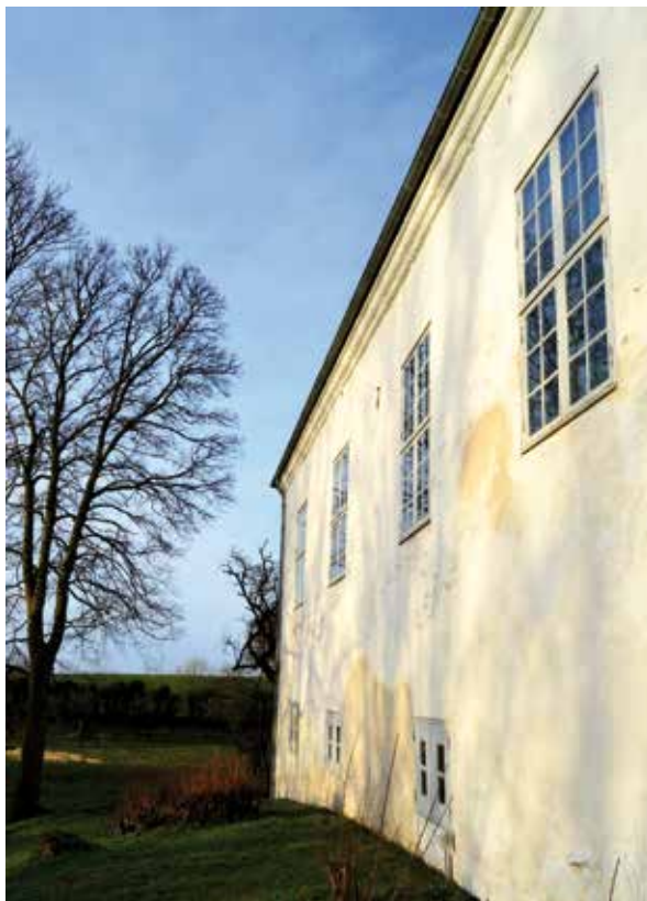
Vestfløjens gård facade. Stik over tilmuret dørhul. Overalt i anlægget findes spor i bygningens murværk, tagværk og sokkel, som fortæller historier om klostrets ombygninger, udvidelser og ændrede brug. Stikket her stammer muligvis fra en korsgang langs kirkens sydfacade. For den, der betragter bygningen med opmærksomhed, rummer de mange spor et væld af historier gennem flere hundrede år. Når man fysisk og konkret kan lægge hånden på en sten, som er formet eller hugget i middelalderen, giver det en følelse af ydmyghed og bevidsthed om at være indskrevet i en historie, som er større end blot ens egen generation. Foto: Maj Bjerre Dalsgaard.
