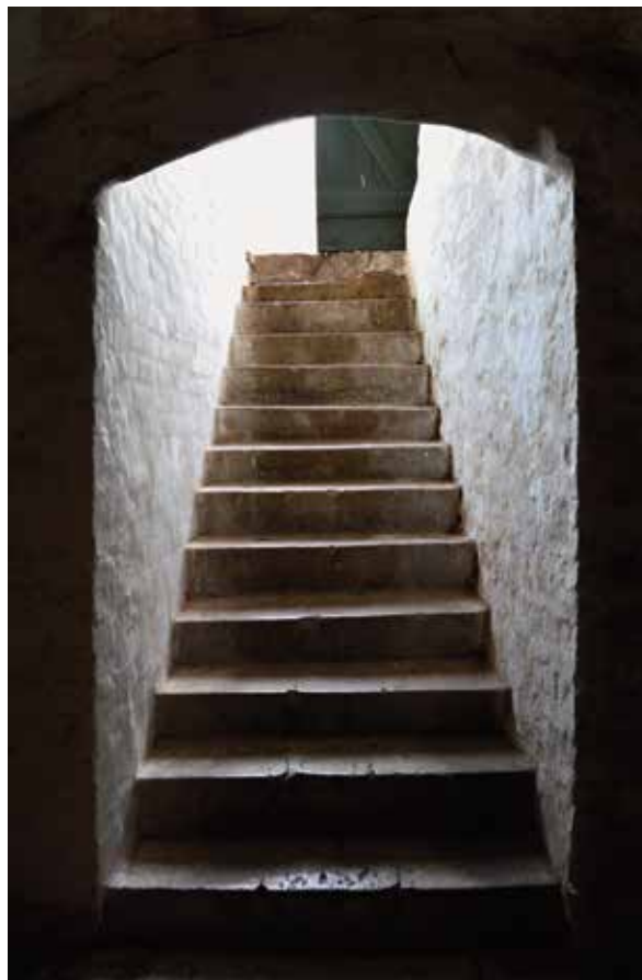
Kælder. Selv den profane opgang fra kælderen til den pikstensbelagte gårdsplads er med sine rå overflader og lysets indfald fuld af stemningsmættet atmosfære. Foto: Maj Bjerre Dalsgaard.
