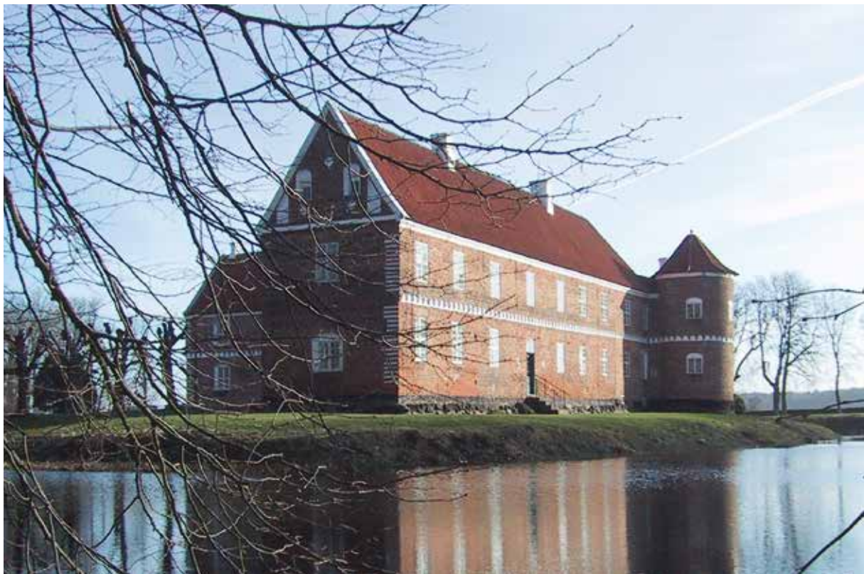
Løvenholm på Djursland set fra sydøst. Østfløjen er opført af Anders Banner cirka 1575, og det sydlige hjørnetårn og fløj opført i 1642. En herregård med klare forsvarssymboler som hjørnetårne, voldgrav og buefriser (dog uden skoldehuller). Foto: Karen Schacht.
