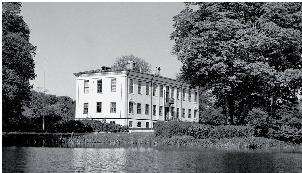
Hovedbygningen på Stenalt. Foto: Poul Petersen.
