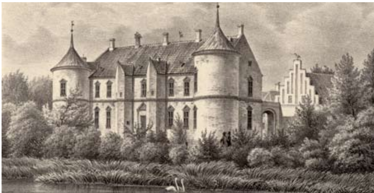
Med støtte fra Realdanias kampagne Fremtidens Herregård skal Lindensborgs kulturelle bygningsværdier sikres gennem eksklusiv udlejning. Ferdinand Richardt 1853.
