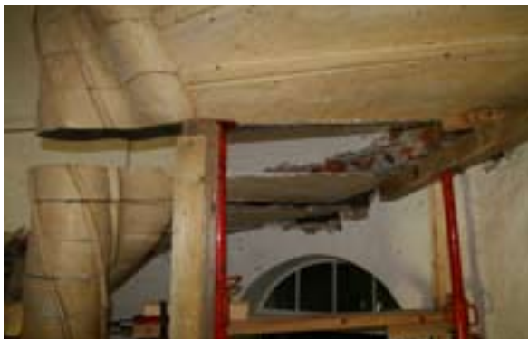
Før og efter: Trappen i det søndre trappetårn blev gennemgribende istandsat. Alle trin blev rettet op og endda i flere tilfælde helt udtaget for at blive restaureret. Efter end restaurering tog trappen sig atter ud fra sin fornemste side, hvor den smukke spindel med udskæringer nu atter kommer til sin ret. Foto: David Slater, Gammel Estrup og privateje.
