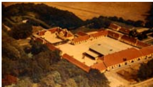
Hele Broløkkens anlæg før nedrivninger af overflødige længer.
