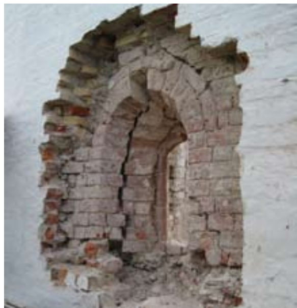
Da de mange lag kalk blev fjernet fra kirkens vægge, afslørede der sig en række spændende ting, for eksempel om datidens mureteknikker, materialevalg samt huller og rester efter de stilladser, der har været i brug under opførelsen af kirken.
