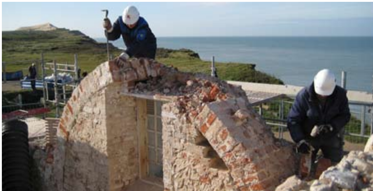
Et arbejde på kanten. Lokale murere i gang med at nedbryde kirkens vestgavl. Buen, som ses i murværket, er den gamle gennemgang mellem kirkeskib og kirketårn. Alt nedbrydningsarbejdet skete med håndkraft, for at bygningsarkæologen kunne nå at se, hvad der skete og dermed dokumentere udvalgte dele i bygningen.
