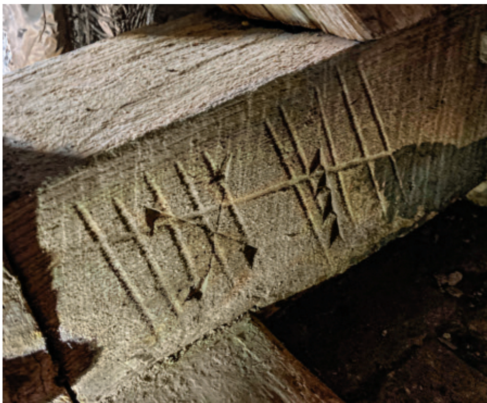
Detalje af tagkonstruktionen på Esrum Kloster. Bemærk de to typer tømmermærker; et med lange, tynde streger, et andet med streger og trekantstik. Foto: Slots- og Kulturstyrelsen.
