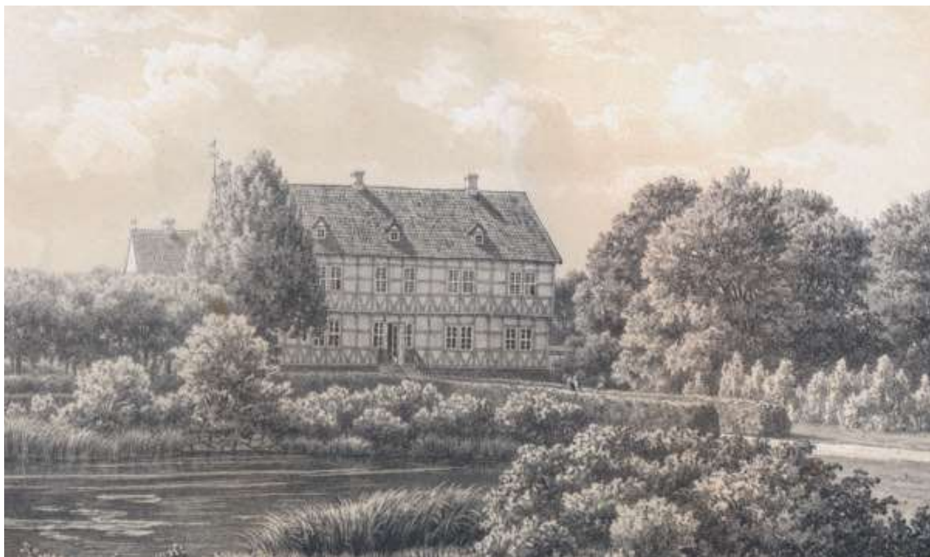
Ryegård, en tragedie ved foden af Hornsherred, Sjælland. Ferdinand Richardt tegnede dette pragthus, et udstyrsstykke i bindingsværk, omkring 1850. Litografiet blev udgivet i 1858. Tyve år senere i 1877 blev det unikke renæssancehus nedrevet, 300 år efter at det omkring 1575 blev opført for rigshofmester Peder Oxes søster Johanne Oxe. På tomten opførte "stationsbyarkitekten" Vilhelm Tvede i 1878-79 et makværk af en herregård i røde maskinsten. Det holdt ikke i 100 år, idet huset blev nedrevet i 1974. Nationalmuseet.
