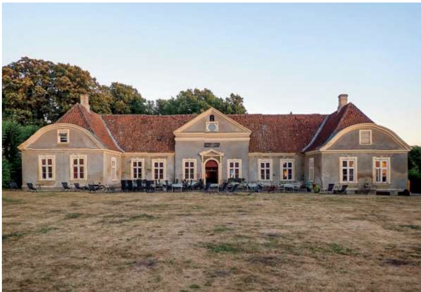
Herskabsstalden, oprindeligt opført cirka 1765, men ombygget år 1800 af Andreas Kirkerup i klassicisme – og i 1883 igen moderniseret af August Klein (1839-1909) med blandt andet cementpuds og store vinduer. Foto: Peter Dragsbo.
