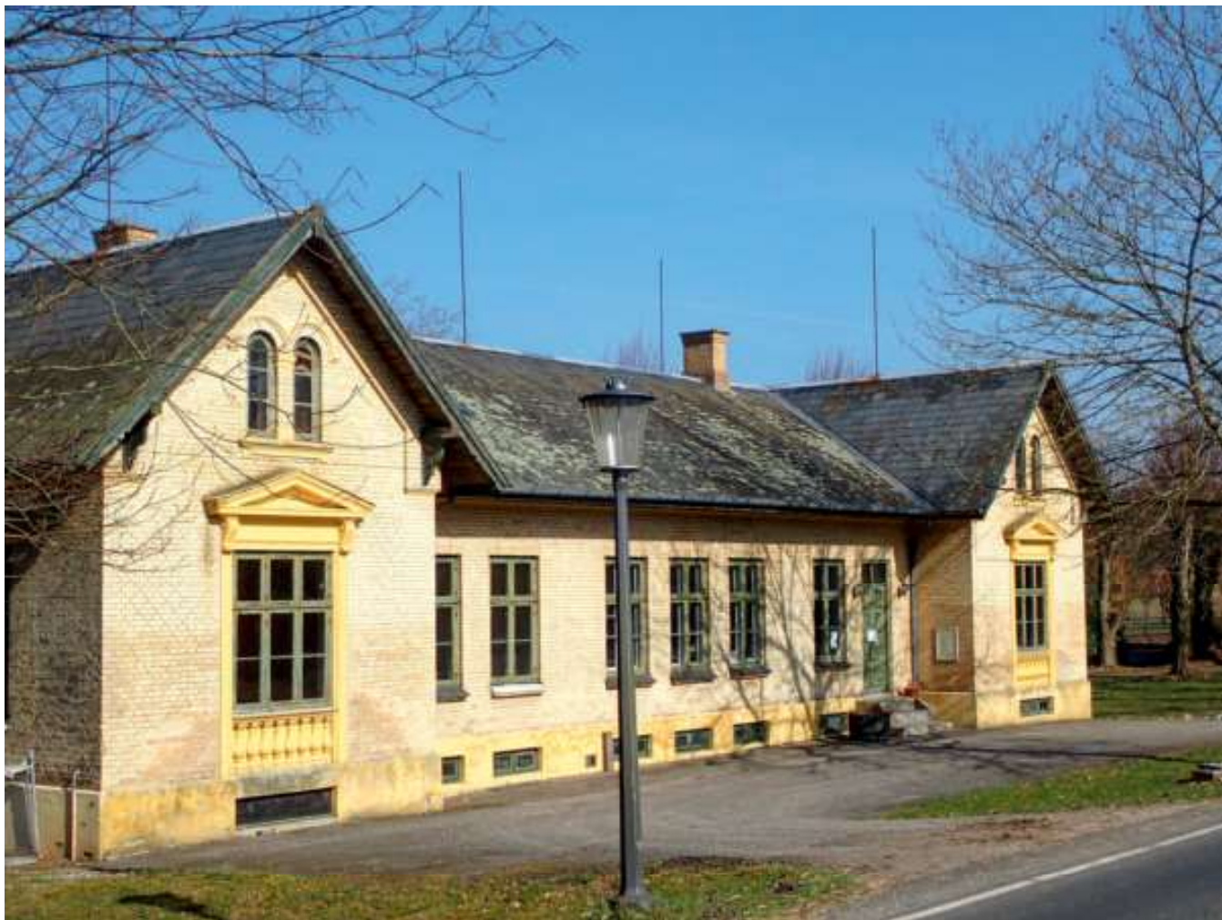
Godskontoret fra 1890 blev August Kleins sidste værk i Tranekær. I 2021-22 er bygningen blevet smukt restaureret af Hans-Michael Jepsens byggekøntor A/S, Stenbjerg Ejendomme ved arkitekt Lisbeth Søkilde. Foto: Peter Dragsbo.
