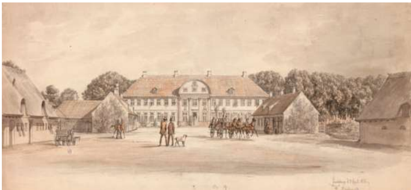
Juelsberg set fra indkørslen. Delvist farvelagt tegning udført i 1854, da hovedbygningens midtrisalit endnu stod med sin oprindelige segmentfronton. Ferdinand Richardt (1819-95).
