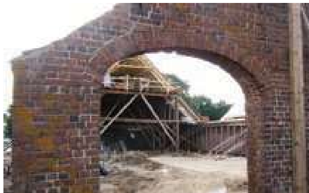
Agerumsladen under ombygning. Den rummer nu en udstillingssal og et forsamlingslokale.
