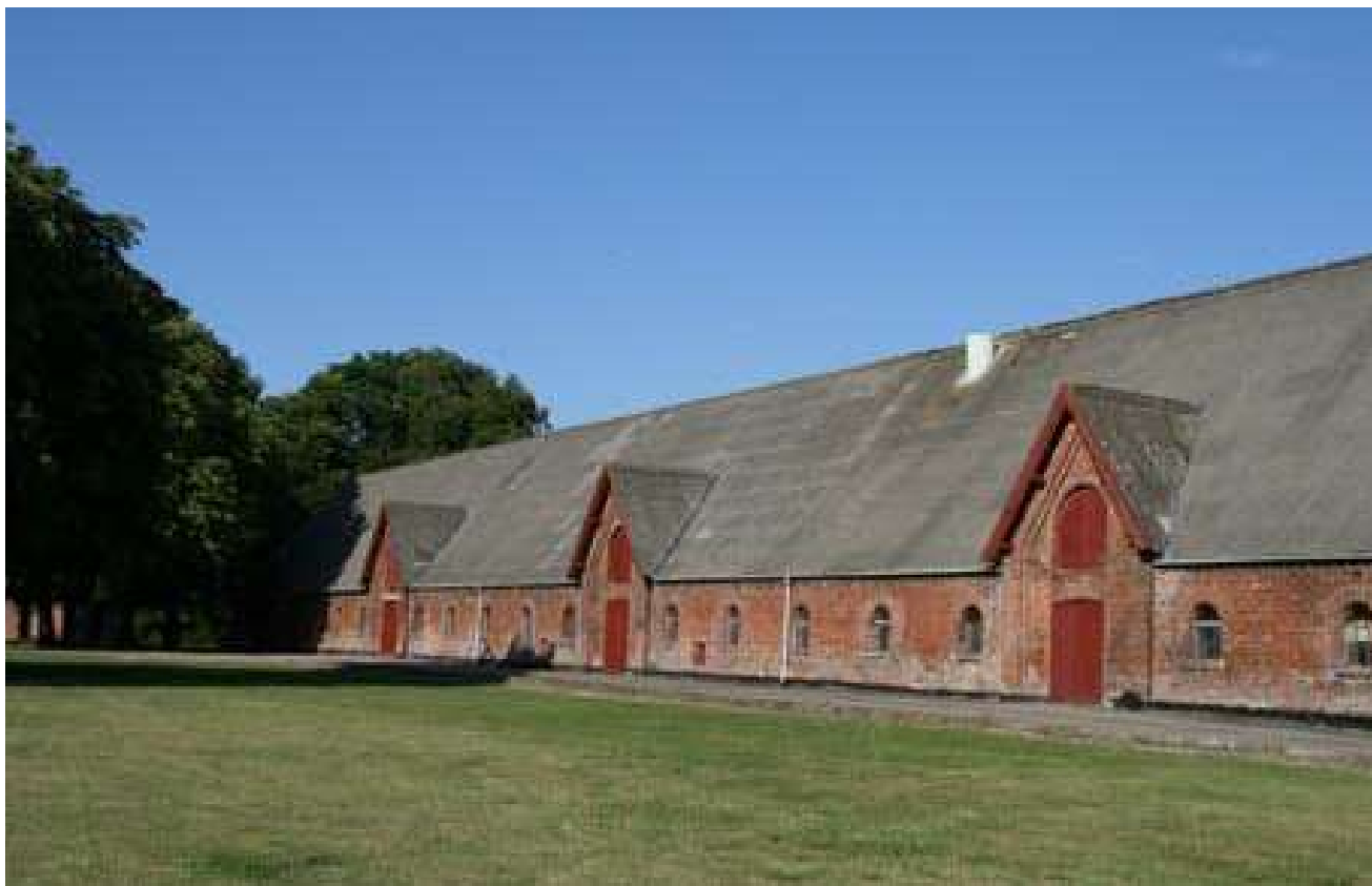
Rosenholms kostalds regelmæssige rytme i facaden vidner om en produktionsbygning, hvor bl.a. funktionen har været dikterende for udformningen. Herudover kan f.eks. byggeskik og symbolværdi have haft indflydelse på udformningen. Foto: Berit Guldmann Hornstrup, Gammel Estrup.
