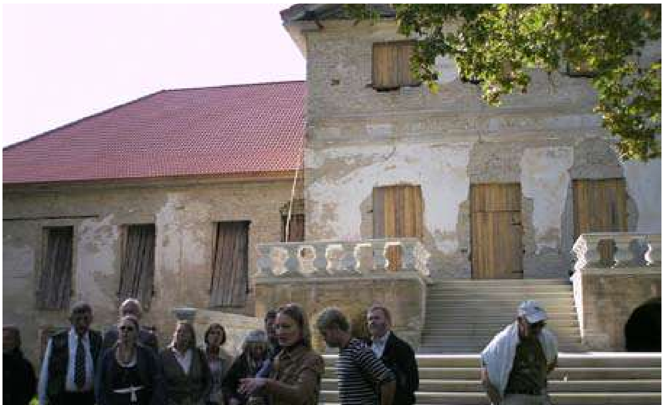
Endnu er der lang vejrestaureringsmæssigt på Raikküla. Alligevel udviste ejeren stor entusiasme og glæde ved stedet. Hvor ejerne havde fundet fragmenter eller dele fra herregården, blev disse rekonstrueret og benyttet i restaureringen. Bl.a. er der blevet støbt nye vaseformede rækværk til terrassen som ses i baggrunden af billedet. Foto: Annemette Løkke Berg.
