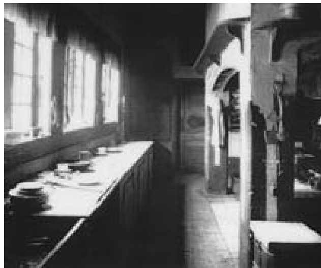
Køkken i Ole Lunds gård, Kalundborg. Anretter-køkkenbordet med vask har den traditionelle placering foran vinduerne. Over for den store gamle skorsten med jernanker over buerne og indsat nyere jernkomfur.
