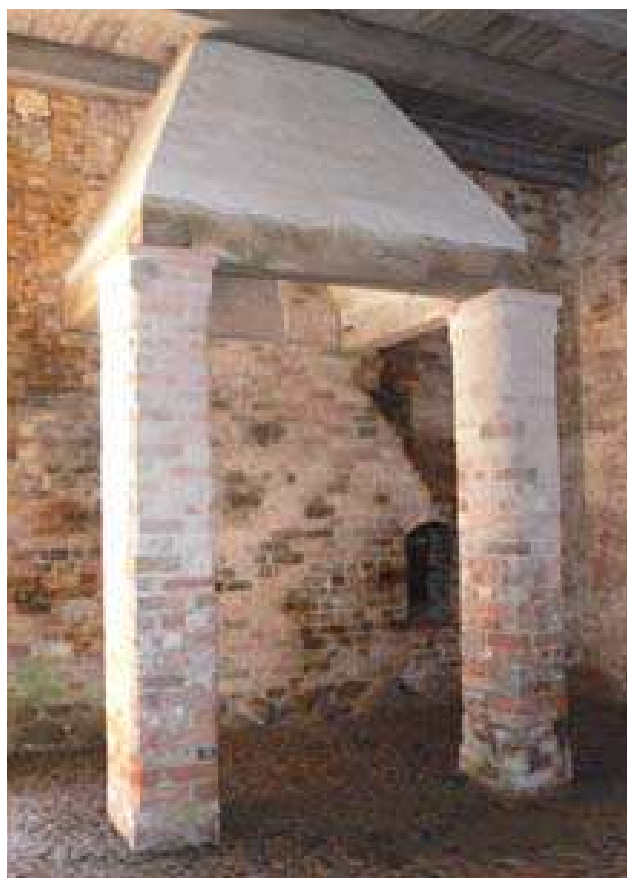
Det store køkkenildsted i køkkenet på Spøttrup fra 1520'erne. Ildstedet bestod af en stor åben skorstens under hvis kappe, der har været en nu forsvundet muret ildbænk, som gav mulighed for at arbejde ved ilden i en behagelig højde. Foto: Bi Skaarup.
