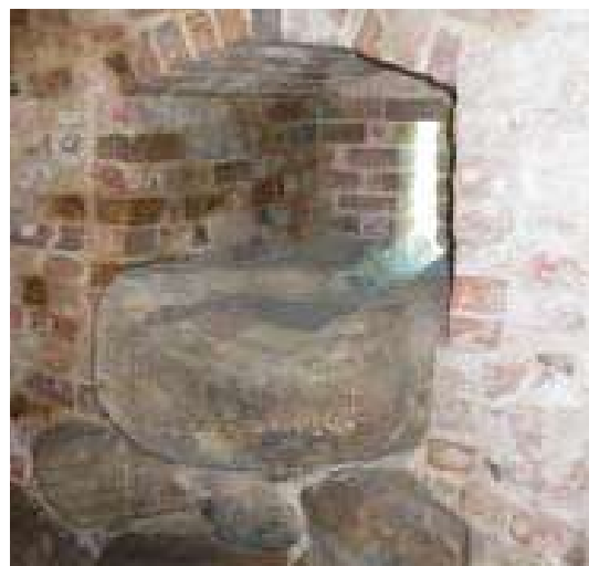
Udslagsvask i køkkenet på Spøttrup fra 1520'erne. Det var vigtigt, at den store mængde spildevand, der produceredes, nemt og hurtigt kunne skaffes af vejen. Derfor var køkkenet udstyret med en vask med afløb i muren ud mod voldgraven. Foto: Bi Skaarup.
