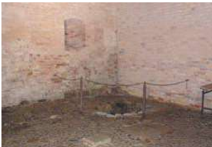
Køkkenbrønden i køkkenet på Spøttrup fra 1520'erne. Vandforsyning i form af en brønd i selve køkkenet, i stedet for uden for, lettede arbejdet med madlavningen betragteligt. Foto: Bi Skaarup.
