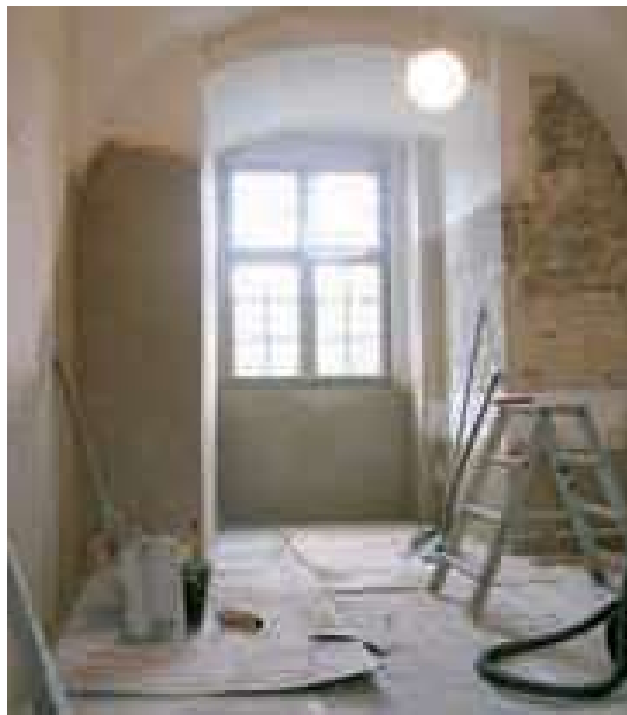
Før Folkestuen kunne genopstå blev lokalet grundigt restaureret og istandsat. Gulvet blev repareret, væggene pudset og kalket og vinduer og døre blev eftergået med maling. Foto: David Slater, Gammel Estrup.
