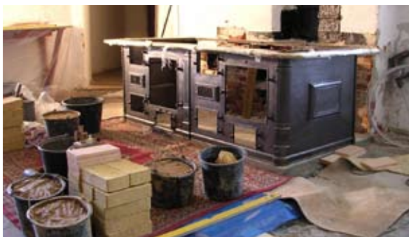
Opstillingen af det nye komfur efter reparation og forstærkning af køkkengulvet. Foto: David Slater, Gammel Estrup, Jyllands Herregårdsmuseum
