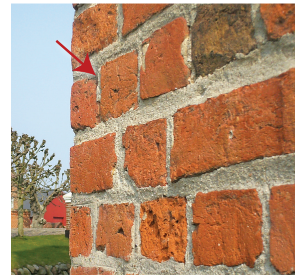
Opmåling af sydtårnet viser, at hjørnerne i bunden af tårnet alle knækker 45 grader på nær to modstående, som knækker 50 grader. Tårnet er altså lidt ovalt. Hjørnemurstenene er alle lavet med et knæk på 50 grader i stedet for 45 grader, som man skulle forvente. Derfor ser hver anden sten ud til at gå lidt ind i murværket på alle de hjørner, der kun knækker 45 grader. Illustration og foto: Niels Bjerre Jørgensen.
